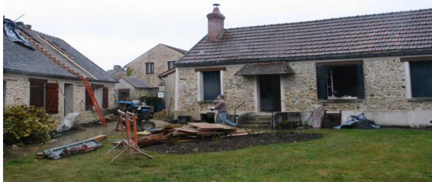
Travaux en cours sur les deux logements locatifs aidés Rue le la Masse
